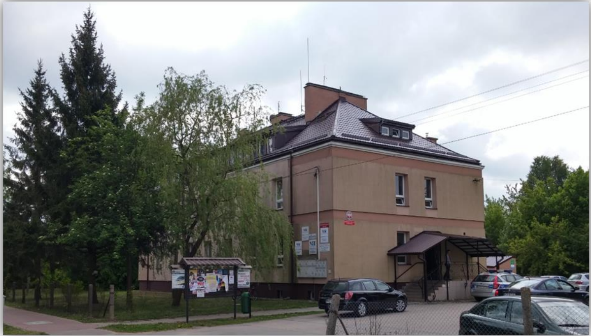
Fot. 5: Budynek komunalny w Myszyńcu, ul. dr. Pawłowskiego 15
